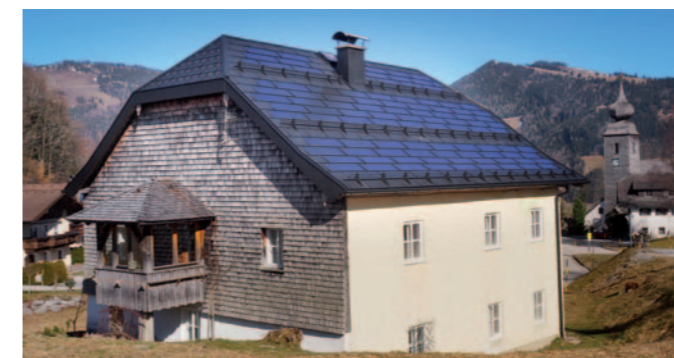
Pfarrhof Krispl: Photovoltaik zur Stromerzeugung ist im neuen Dach technisch und optisch integriert
