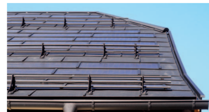
Pfarrhof Krispl: Photovoltaik zur Stromerzeugung ist im neuen Dach technisch und optisch integriert
